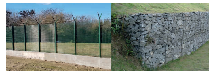
Imagen 3.2. Fotos de activos de infraestructura física
