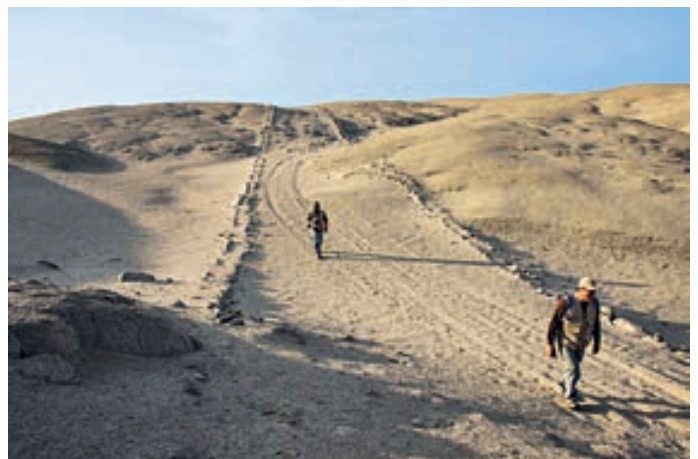
Camino precolombino en Manchán (costa de la región Áncash) A los lados de este camino, se observan las bases de lo que alguna vez fueron los muros que lo flanquearon para evitar la afectación por arena. Fuente: Ministerio de Cultura del Perú (2013)
