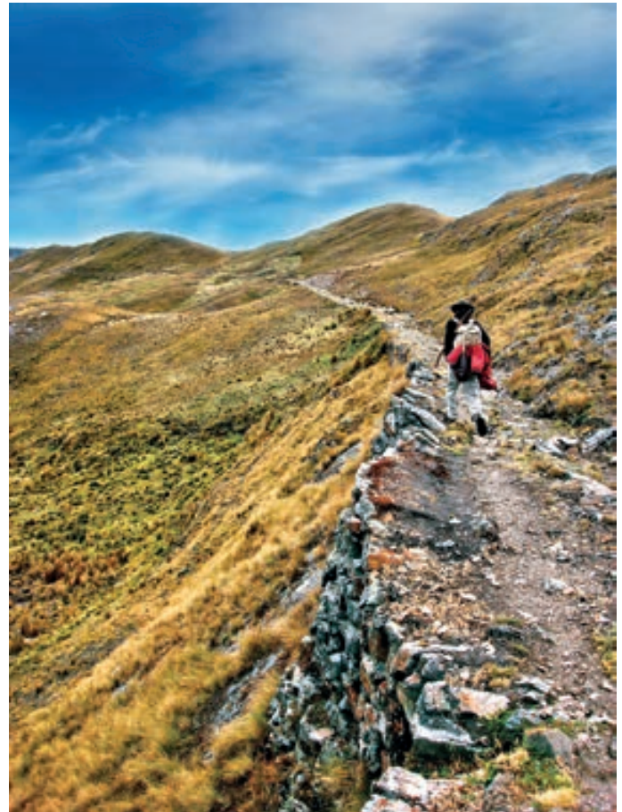
Sector del Qhapaq Ñan entre los poblados de Ayash y San Cristobal de Tambo (región Áncash) Los caminos de la sierra fueron elevados para sortear la ero- sión de los suelos y facilitar el drenaje del agua. Fuente: Ministerio de Cultura del Perú (2009)
