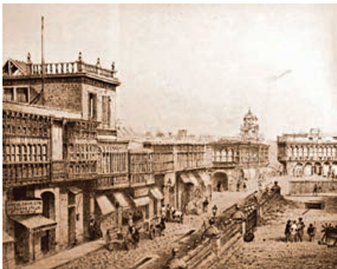
Obras de alcantarillado, empedrado y alumbrado a gas (1867) Fuente: www.skyscrapercity.com/showthread.php?t=402169&page=18&langid=5
