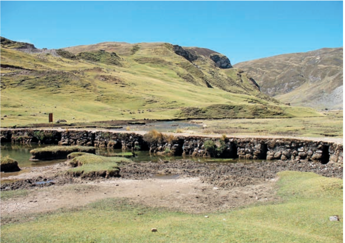
Puente sobre río de cauce ancho Múltiples columnas sostienen este puente de piedra inca aún en uso sobre las nacientes del río Lauricocha, en las alturas de la región Huánuco. Fuente: Ministerio de Cultura del Perú (2008)
