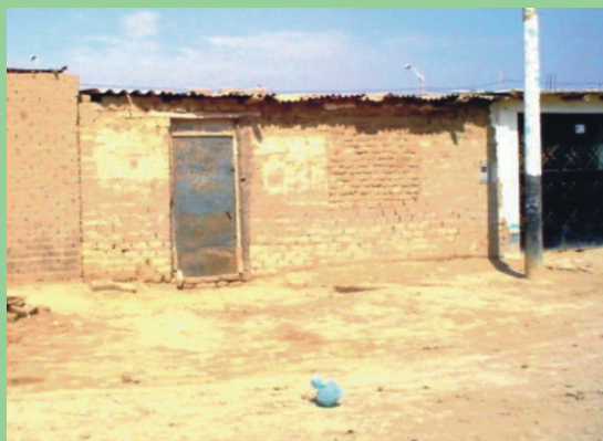
Vivienda de material de adobe
