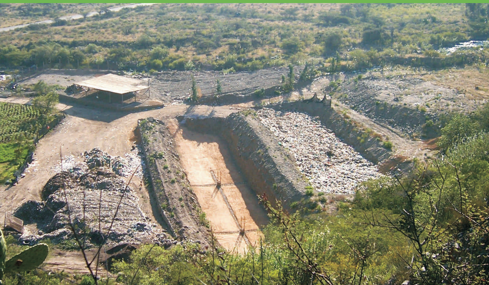
Planta de Tratamiento de Residuos Sólidos y Relleno Sanitario de la Ciudad de Caraz, Municipalidad Provincial de Huaylas, Región Ancash
