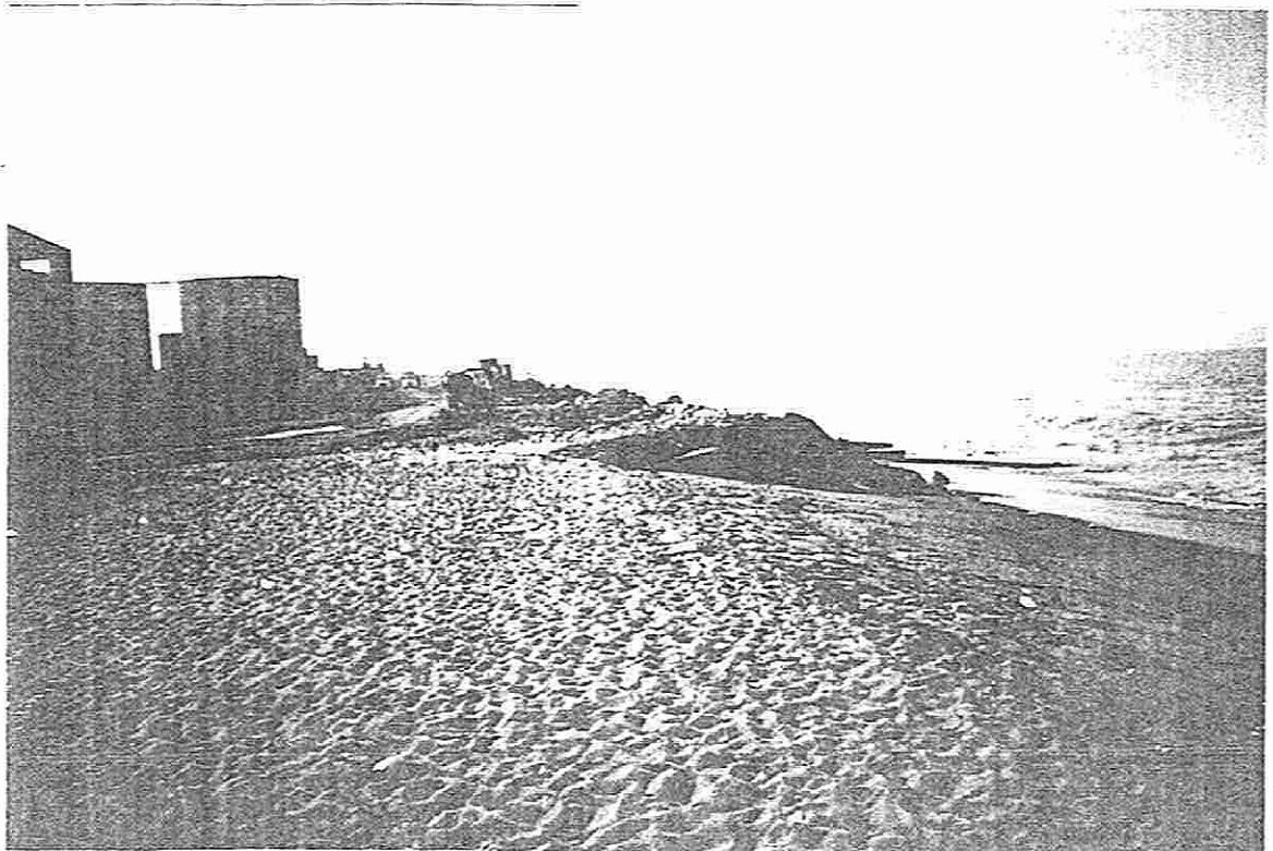
Fábrica ALIMARSA con playa arenosa, muros de defensa con núcleo de materiales de desmonte.
