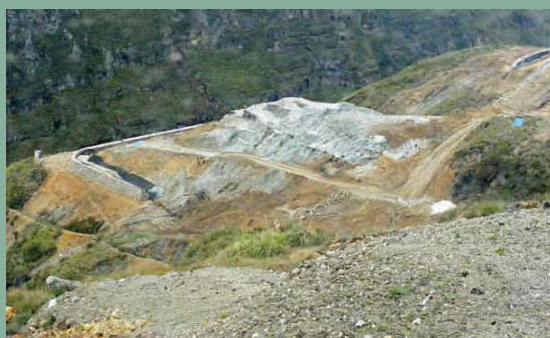
Restauración de pasivo ambiental. Empresa Colquirrumi. Provincia de Hualgayoc
