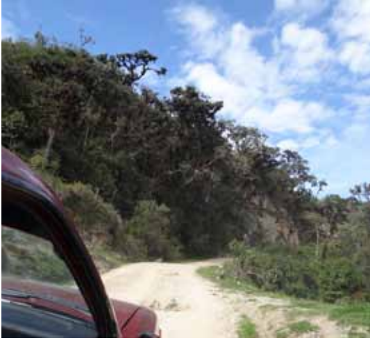
Carretera Chadín - Choropampa, Cajamarca. Nótese cómo el bosque ha sido atravesado por la misma. Foto: M. Stucchi [2012].
