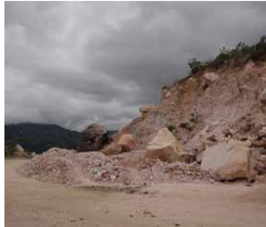
Corte de ladera para ampliar un tramo de la carretera Lonya Grande - Ocallí, Amazonas. Foto: M. Stucchi [2012].
