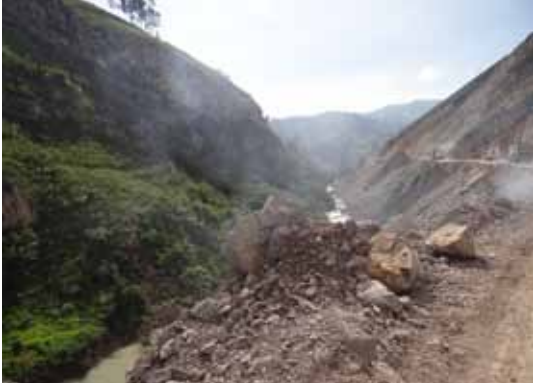
Rehabilitación de la carretera Chota - Cochabamba, Cajamarca. Nótese cómo se arroja el material excedente al río Chotano y el levantamiento de polvo. Foto: M. Stucchi [2012].
